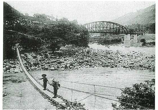
第二木曾川橋梁（明治42年9月完成）
