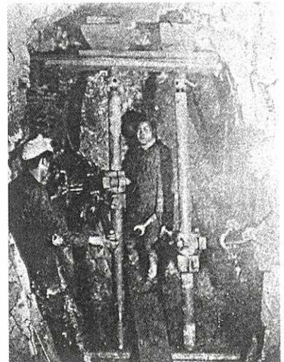
笹子トンネルで使用のアメリカ製削岩機
