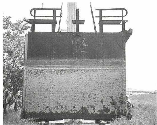
修復前の門扉の状況（提供・田原製作所）
