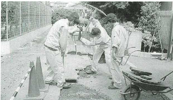
実際の道路のアスファルトを カッターで切れ目を入れてはがす。 はがしたアスファルトは一時保管し、 再生利用の方法を模索している
