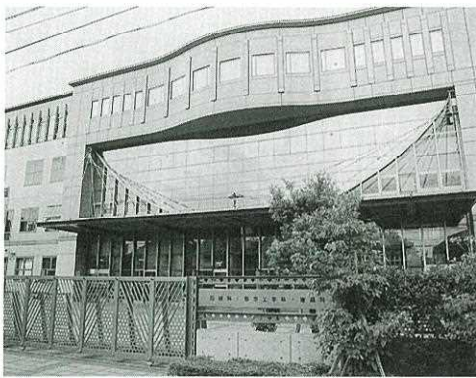
正門からみた田無工業高校。校舎は1999年に改築された
