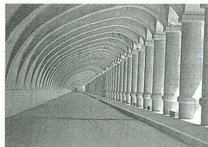
稚内港北防波堤ドーム
