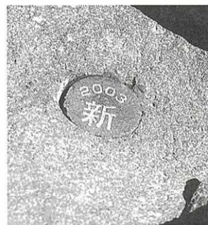
加工して場所をかえて使った石材と新規に用いた石材。再加工石は「2003再」、新規石は「2003新」の刻印を入れている。
