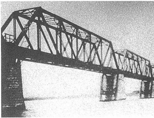
雄物川橋梁（1919年）
