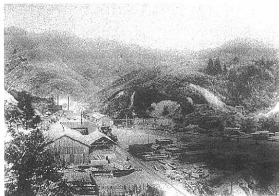
折渡トンネル工事（岩谷口）
