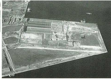
② ひびきコンテナターミナル (工事中写真)
