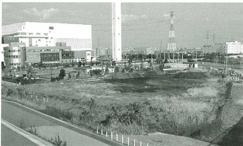
環境と経営はウィン・ウィン関係に (写真：千葉県市川市のPFI事業「クリーンセンター余熱利用施設整備・運営事業」)
