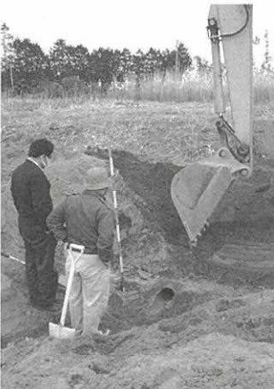
現場は更地になっていた業者が重機で慎重に砂をとり除き、地面から約1.5mのところ暗渠が見つかった
