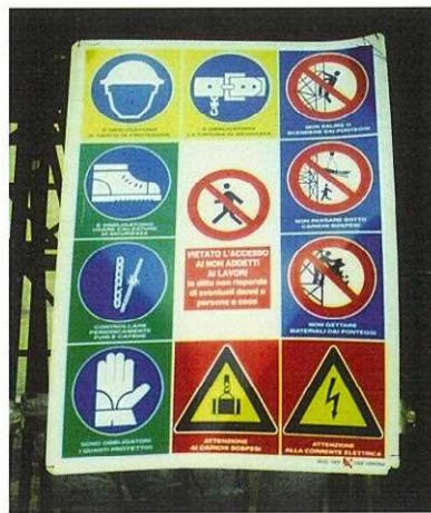
写真1. イタリアの工事現場のピクトグラム 誘目性が高く、明かな表示でわかりやすい。
