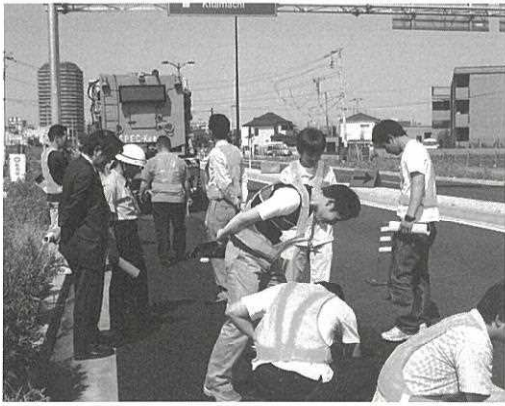
機能回復作業後の路面を点検する受講生
