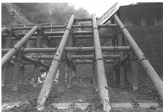
白水谷第2号砂防堰堤
