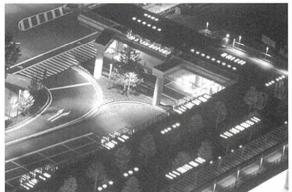
写真3 さいたま新都心東側歩行者デッキの夜景 床面に埋め込まれた人を誘導するために配置された光は床面照度を確保していない。計算上はゼロルクスである。
