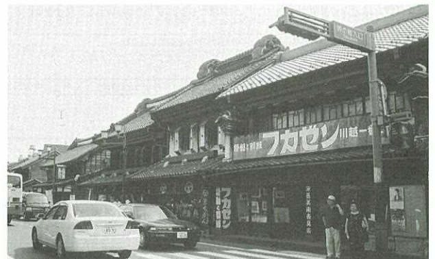
川越の蔵造りの特徴は、黒漆喰仕上げの店蔵、大きな棟と影盛、重厚な軒蛇腹、観音開き扉などにある。
