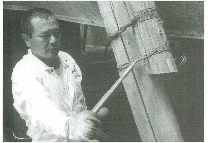
「巻き線」と呼ばれる丸太の重ねせ継手の縛り方(木下氏による実演)
