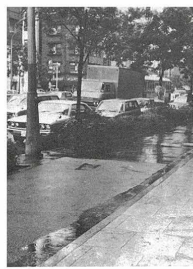
左側手前が透水性歩道舗装 (透水性舗装ハンドブック 2) より転載)
