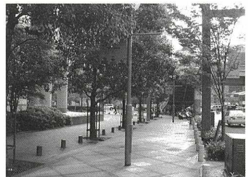
写真4 曾根崎通り 歩道中央に街灯を配している。左側の公開空地の緑がアメニティを高めている。
