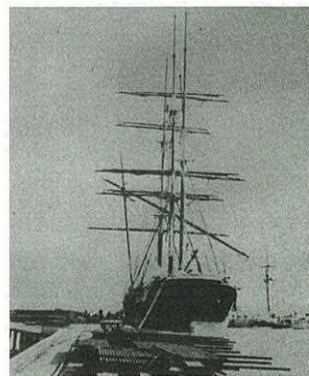
建設資材積載の帆船 ジラルド・シ・トベイ号
