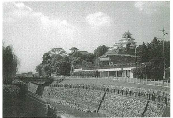
コンクリート三面張りを石張りに改め、乱石を置いて改良した逆川と掛川城木造復元天守（右）と太鼓櫓（左）
