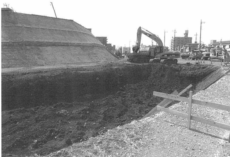
宇都宮城復元工事中の土塁と堀
