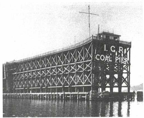
室蘭高架橋（石炭船積み用・1911年完成）
