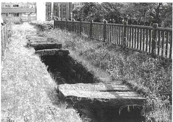
本郷給水所公苑の神田上水石樋。幹線水路の一部で上幅 150cm 高さ 120~150cm。蓋石が乗っている
