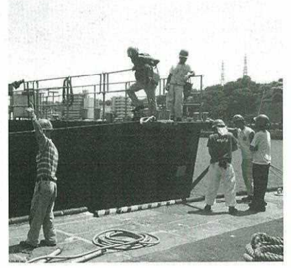
右・船の入渠後、扉船を閉める様子 オッペシ棒を使って扉船を据え付けている 左・トランシーバーで職人達に指示を与えるドックマスターの神川彰氏 下・入渠の最終確認の作業風景 盤木の位置の微調整等が行われる
