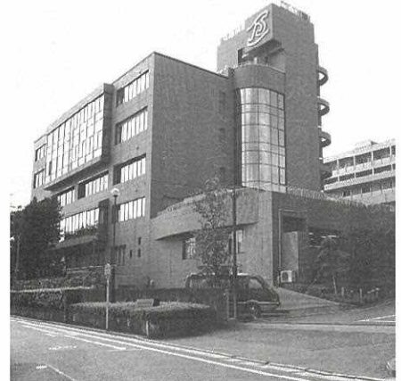
埼玉県戸田市にある荒川処理センターに隣接する日本下水道事業団の総合実習棟および本館。周囲は荒川の自然を利用した公園などがある
