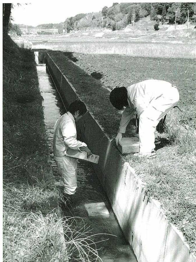
写真5 エコブロックの設置
