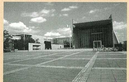
メインアプローチから見た埼玉県環境科学国際センター。右側の大きな建物が展示棟、左側は研究棟
