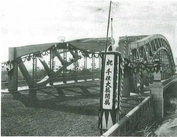
千住大橋 昭和2年開橋祝い (写真提供・大林組)
