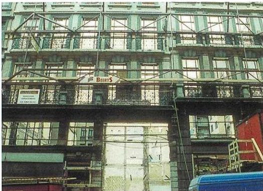
外壁1枚だけを残し、内側を壊して改修工事するパリの建物
