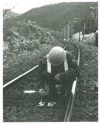
保線作業風景
