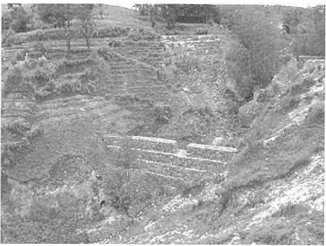
ネパール国ダバケルモデルサイトの被災状態と災害復旧（2003年に土石流災害が発生）
