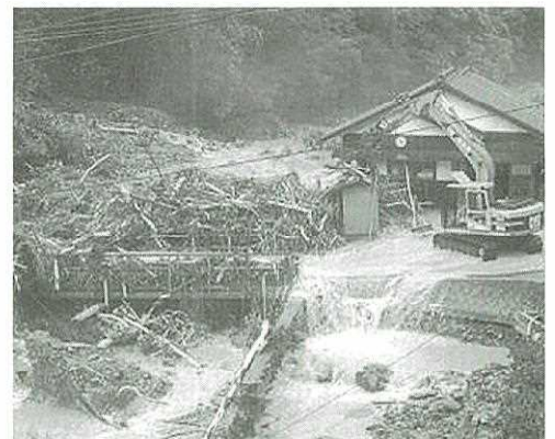
写真6. 避難所の被災事例
