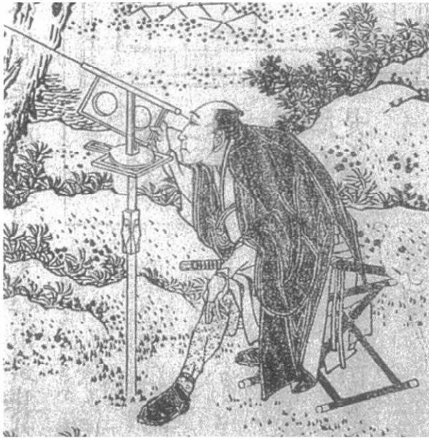
大方儀で垂直角を測る図（「量地図説」より）
