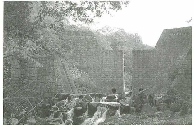
外ノ沢砂防ダム
