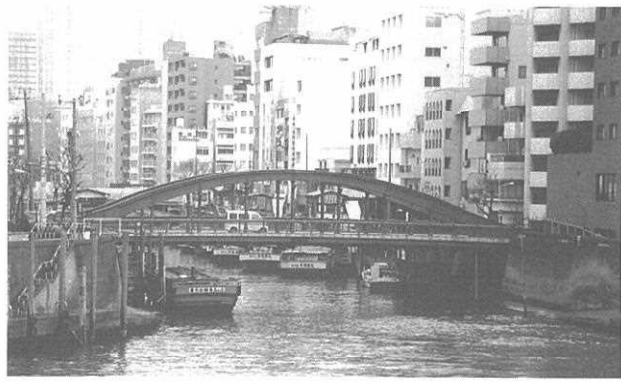
柳橋の船留り。柳橋架橋以前にあった渡船は明暦の大火の遺体を回向院に搬送したため、「三途の渡」と呼ばれた
