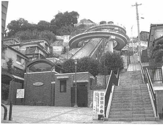
写真9. 長崎市・斜行エレベーター
