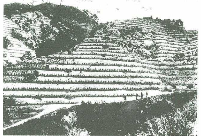
山腹工施工後1年目（明治37年）
