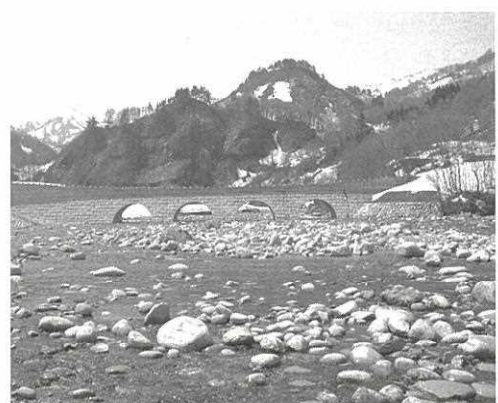
写真3. スーパー暗渠砂防堰堤
