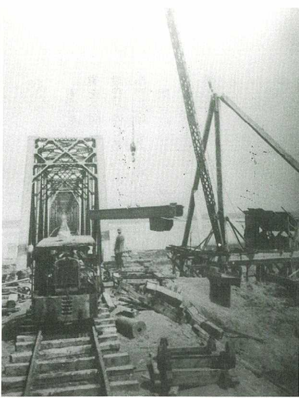
材料積み込みと運搬（吉野川橋梁工事）
