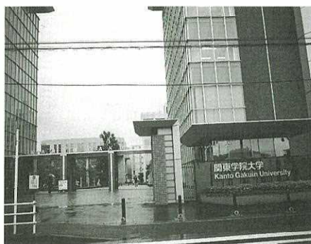
高層の新しい校舎が整備された 関東学院大学の正門
