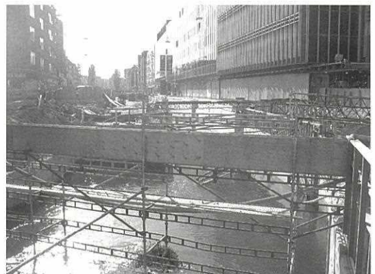
写真5. デンマーク・オーフスの河川復旧
