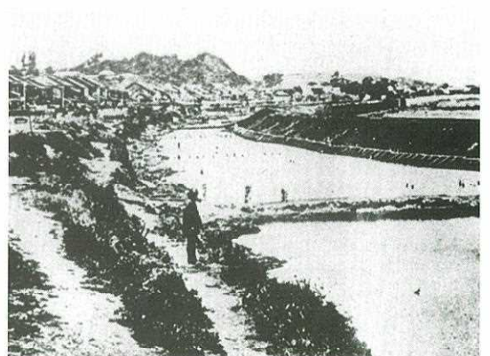
高輪海岸の築堤工事（明治5年9月完成）
