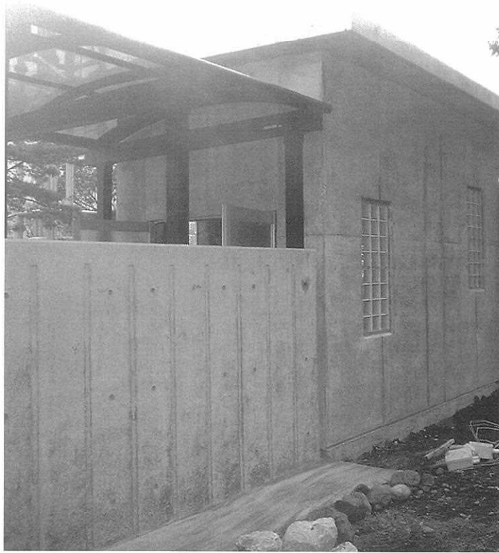
建築基礎多能工コースの終了作品 (RC建築)
