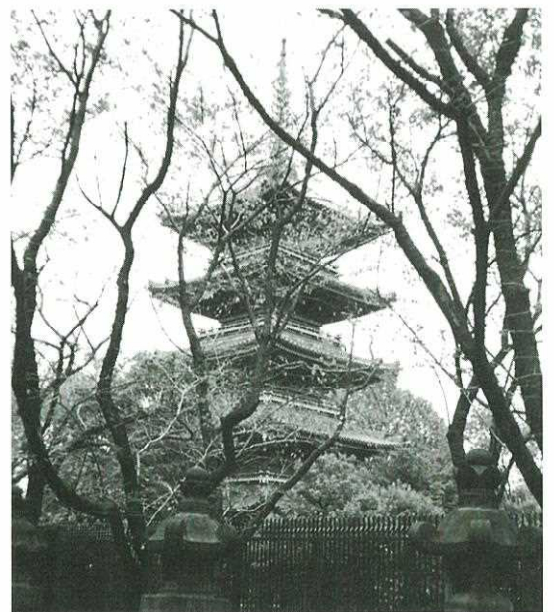
「湯島から壱万石の塔が見へ」と川柳に詠まれた寛永寺の五重塔は大老土井利勝が寄進した(重要文化財)
