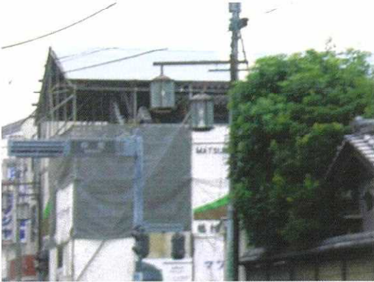
つぎはぎ つぎはぎの防護シートは、景観を壊す要因にも。
