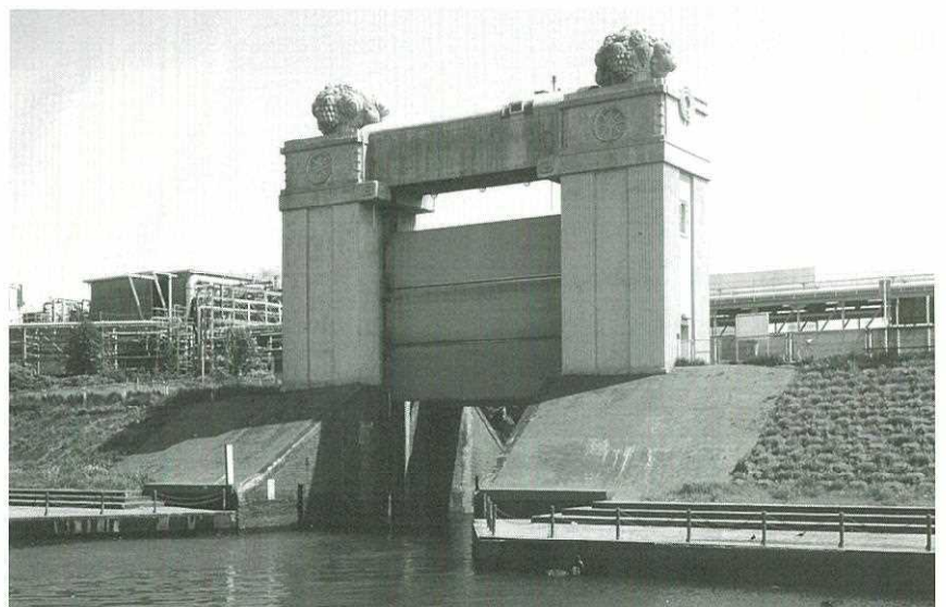
写真5 川崎河港水門：神奈川県
