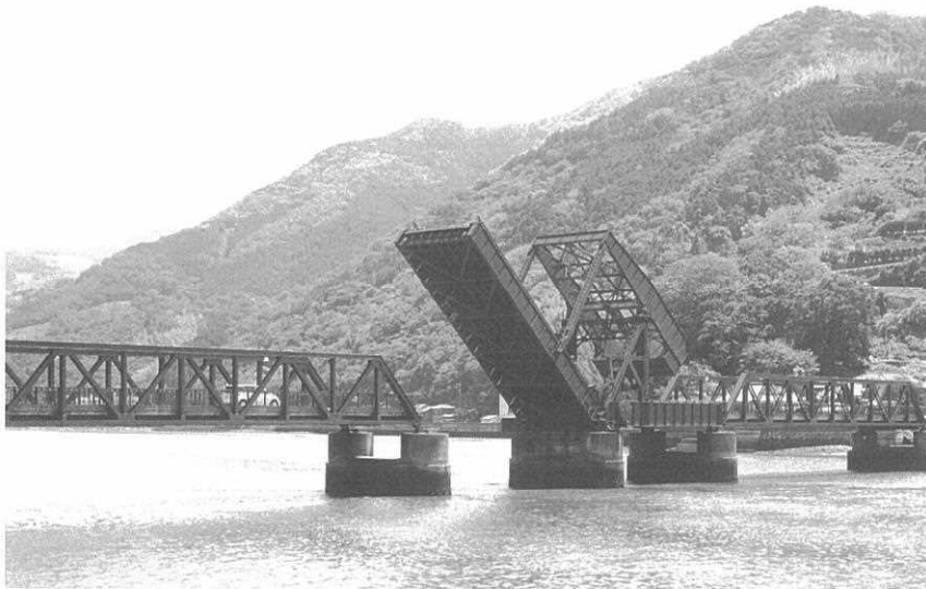
写真6 長浜大橋：愛媛県
