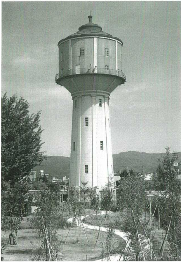
写真4 水道タンク：新潟県
