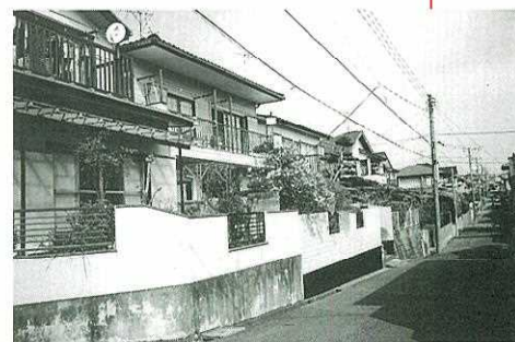
木造の戸建て住宅が整然と並び、調査地の住宅街
