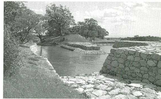
写真4. 象の鼻の野越（砂止め機能） 象の鼻の付け根の野越から水が入ると、象の鼻先端部から回り込んでくる水の流れ（写真右手）が止まる
