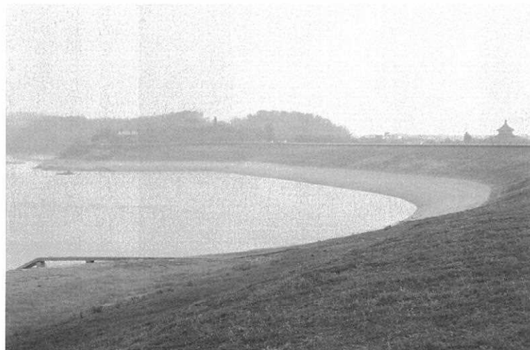
台湾・烏山頭ダムの堰堤
