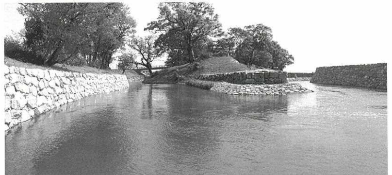
写真2. 天狗の鼻を中心とした全景 象の鼻から下流方向：右手が象の鼻、真ん中が天狗の鼻、左手が導水路 大井手堰でせき上げられた水は象の鼻先端部(右手)から入り、天狗の鼻を回って左手の導水路を流れる
