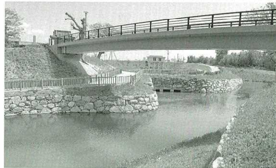
写真5. 出鼻（洪水時の水はね：洪水戻し） 3連の石閘の手前で導水路の護岸が直角に曲がり、導水路の幅が狭くなっている。これは、洪水時に水を放水路方向にはねるためのもの
