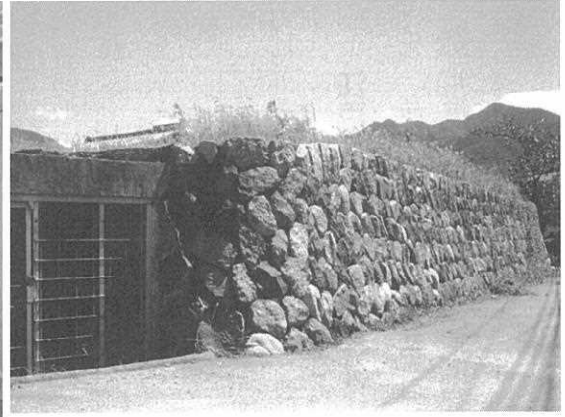
龍憲セラーの内部と石垣
