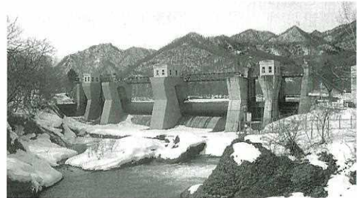
藻岩発電所・取水堰（北海道）
