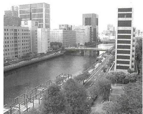
護岸整備した「高浜運河」(港区)
