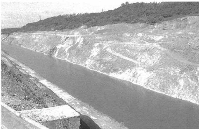
建設中の掘浦川放水路（京仁運河）
