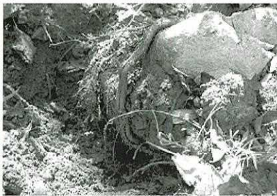
「柳枝工」施工2年後には、根が石を掴み一体化
