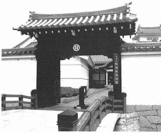
白いしっくい壁、和瓦を用いた正面ゲート
