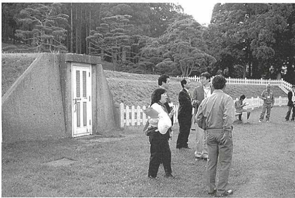
元町配水池 水道創設時の姿をとどめている
