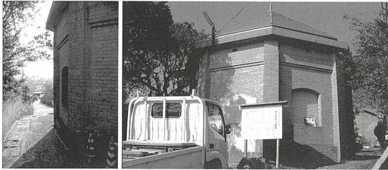
宇部市の桃山配水計量室
