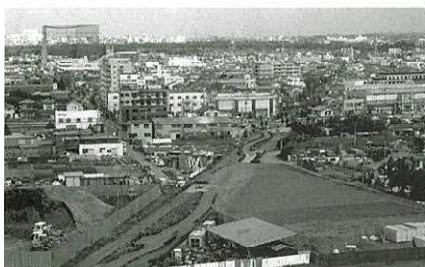
相模原市麻溝付近
