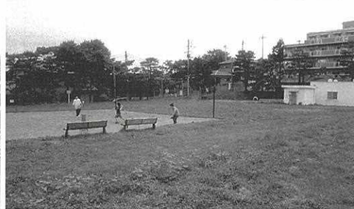
荒巻配水所配水地（仙台市）
