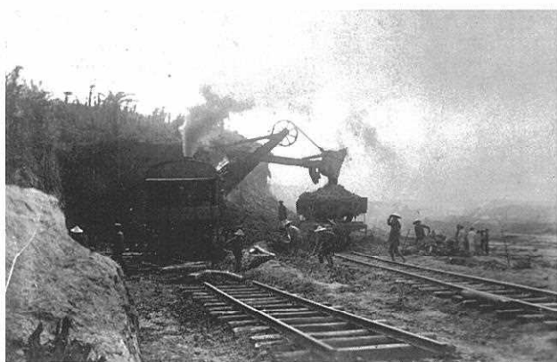
大型スチームシヨベルによる作業 (嘉南農田水利会提供)
