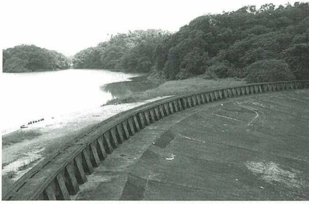
烏山頭ダム・余水吐
