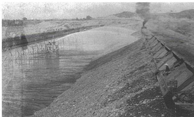
セミハイドロリック・フィル工法による堰堤盛土と射水作業 (嘉南農田水利会提供)
