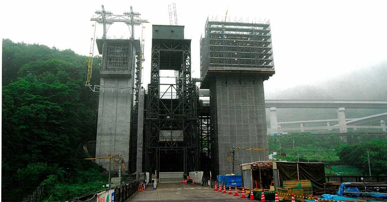
裏高尾橋工事の現場 橋脚には須田さんが開発に係わった、優れた耐震性と経済性を備えたスーパーRC工法が用いられている
