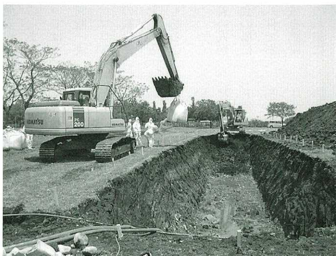
深さ4～5mを要した埋却作業は、掘削、家畜埋却、埋め戻し、全体消毒といった手順で、過酷な条件下におこなわれた
