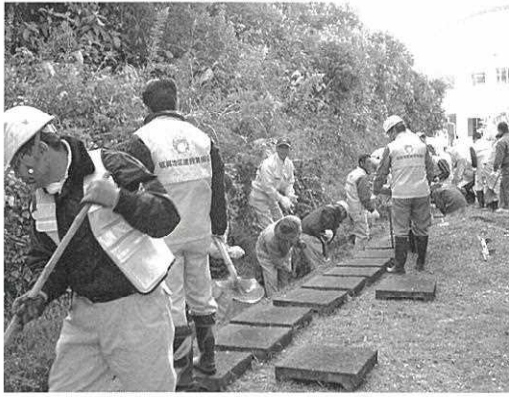
地区建設業協会による地域社会貢献活動（側溝清掃）
