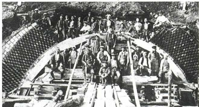
写真4 工事中の丹那トンネル
