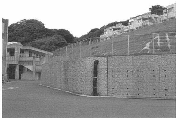
ホープ設計が携わった橋梁点検調査と災害防除擁壁工
