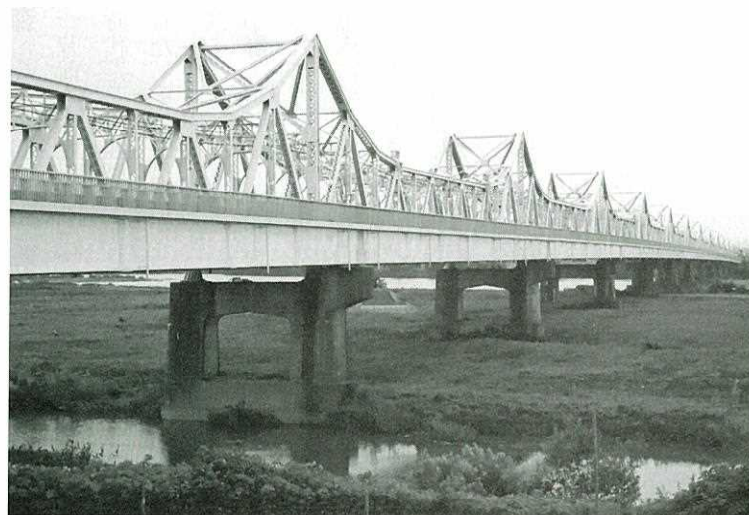
長生橋(1937年竣工、日本で唯一現存する多連・上曲弦方式のトラス橋)
