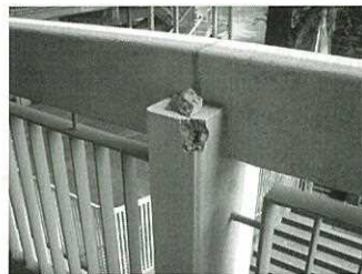
写真1. バルコニー手摺り改修
