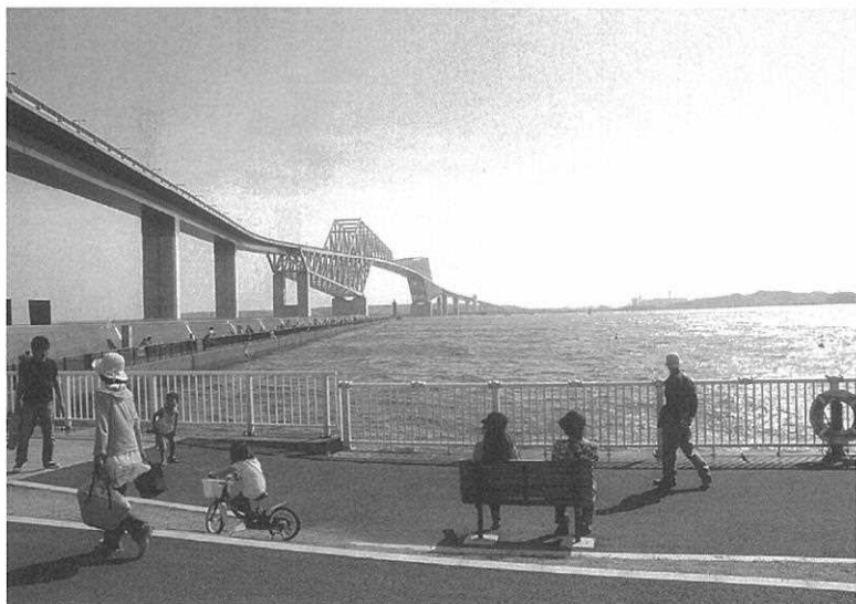
東京ゲートブリッジ
