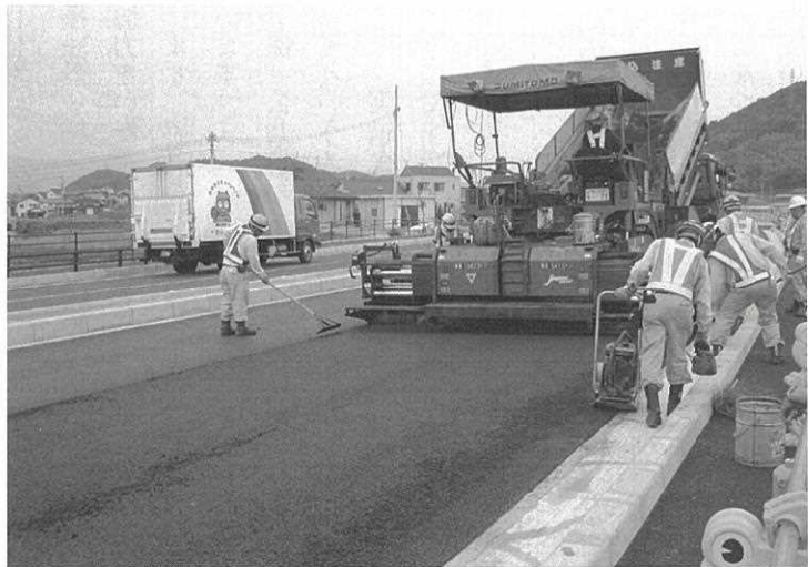
アスファルト舗装の舗設
