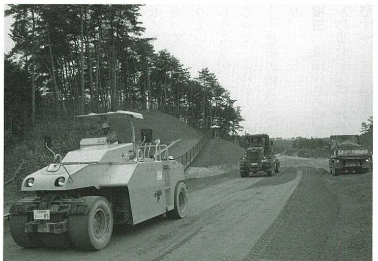
路盤材の転圧
