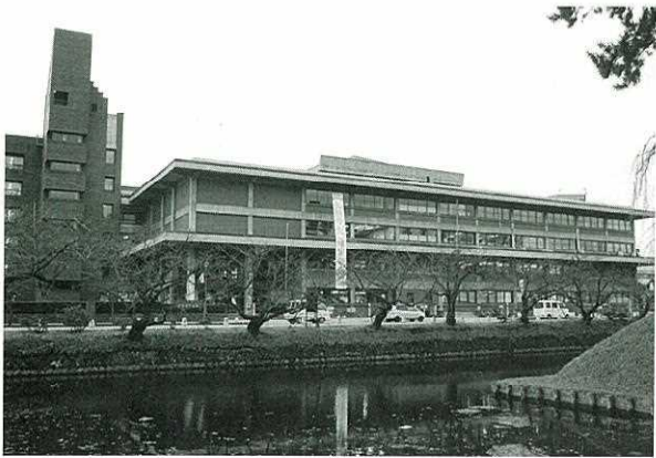
弘前城のお堀端に建つ市庁舎
