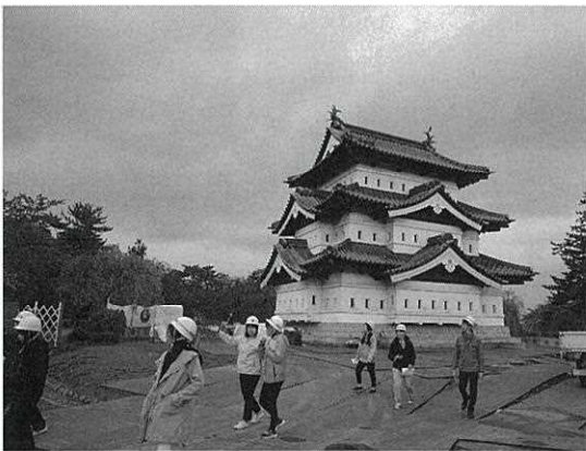
弘前城曳家工事現場を視察
