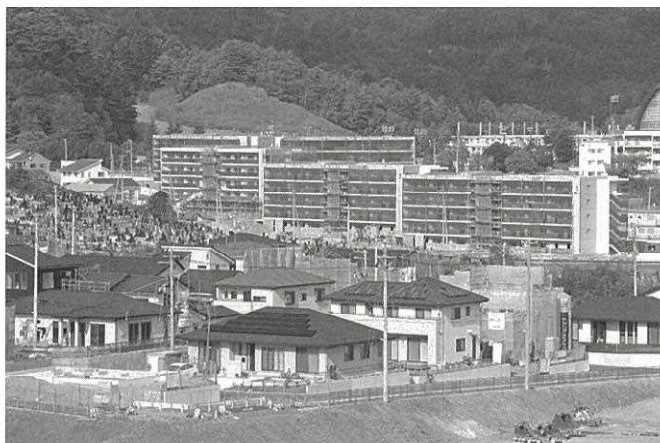
高台の造成宅地では住宅や災害公営住宅の建築が進む女川町
