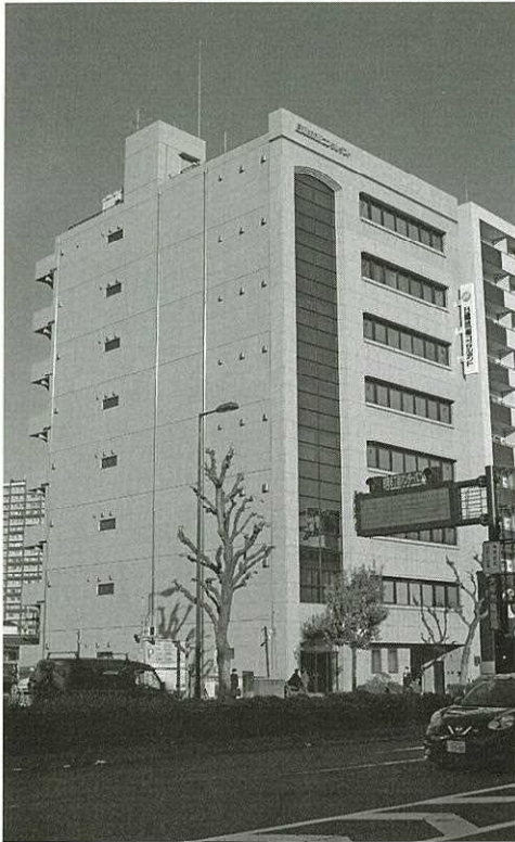
本社ビル（大阪市中央区谷町六丁目4番3号）
