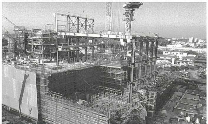
日建技術コンサルタントが担当した 道頓堀川水辺遊歩道整備（大黒橋～新戎橋）の設計業務と 東京都・ふじみ衛生組合ごみ焼却施設の施工監理業務
