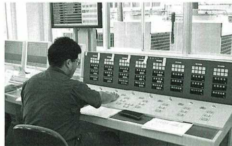
写真6 操作係のゲート操作状況(利水ダム・第一類ダムの5門のワレストゲート)。その他4カ所の警報所のサイレン吹鳴を実施
