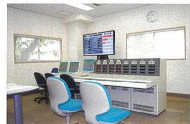
ダムシミュレータ室
