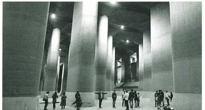
写真2. 防災地下神殿と呼ばれる人気スポット 首都圏外郭放水路（埼玉県）
