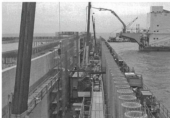
写真2. 羽田D滑走路工事 接続部工区鋼管井筒部の施工
