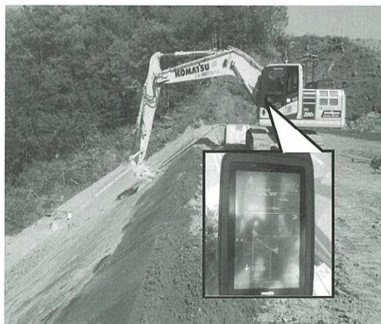
ICT建機による法面整形（小松市産業団地造成工事）
