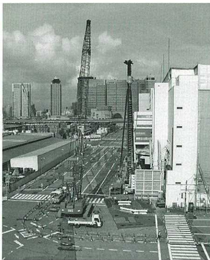
写真1. りんかい線工事 週末昼夜連続での山留壁施工
