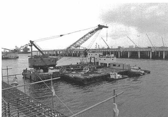
写真3. 羽田D滑走路工事 資材運搬の様子
