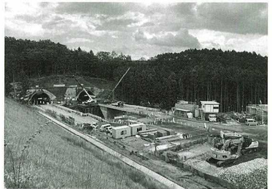
写真1. 新東名高速道路湯船原トンネル工事 上野工区トンネル西坑口部全景
