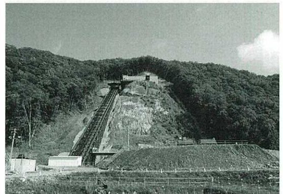
写真1. 豊平川水道水源水質保全 導水路新設工事その1 発進基地全景
