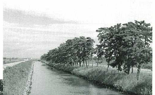
写真1. 保全された貞山運河
