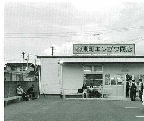
仮設商業施設「東町エンガワ商店」
