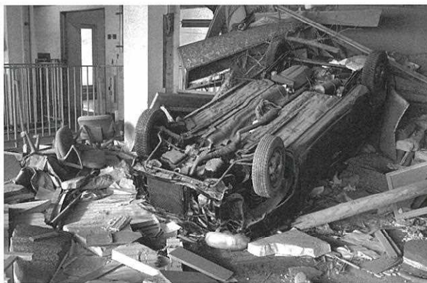
南校舎3階には漂着した車が仰向けのまま残されている
