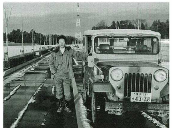
大規模造成工事（準幹線道路にて）
