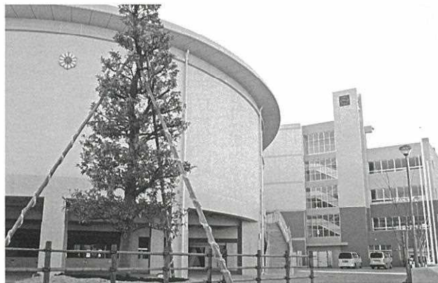
竣工した新設小学校 手前はワークショップ参加者で植えたシンボルツリー
