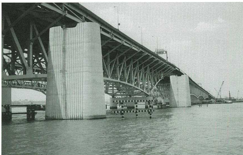
担当した荒川河口橋の壁式橋脚
