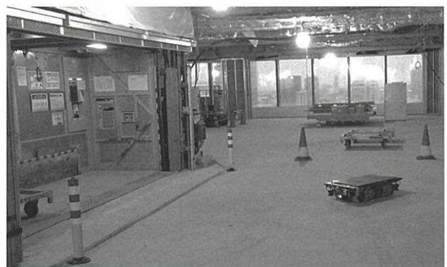
写真1. 現場内の資材搬送の自動化
