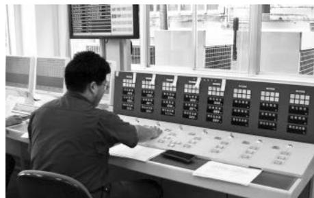
写真6 操作係のゲート操作状況(利水ダム・第一類ダムの5門のクレストゲート)。その他4カ所の警報所のサイレン吹鳴を実施
