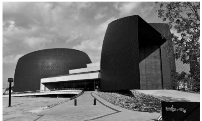
あかがねミュージアムは、その名のとおり外壁には「あかがね=銅」の板が流線状に張られている
