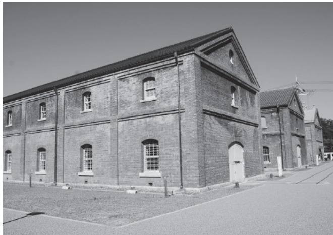
旧海軍が築いた赤れんが倉庫群一帯は「赤れんがパーク」として整備されている
