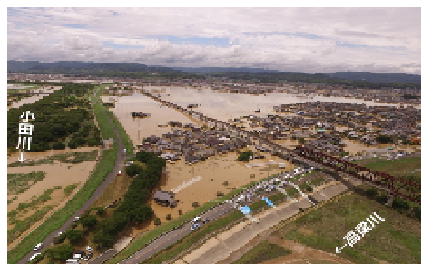
◆H30.7月豪雨「小田川における浸水被害(岡山県倉敷市)」
