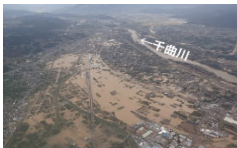
◆R1.東日本台風「千曲川における浸水被害状況(長野県長野市)」
