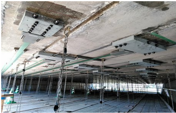
上部工の補修工事
