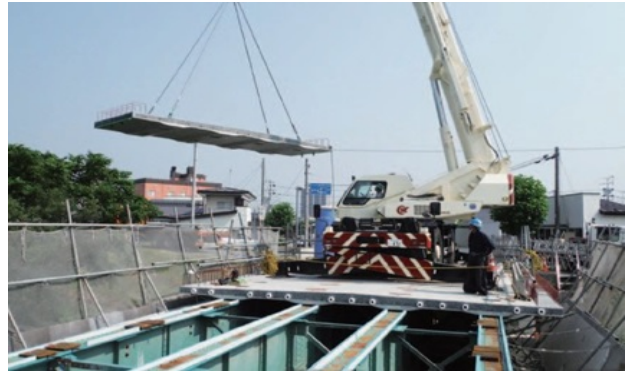
床版の補修工事
