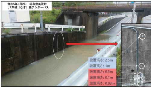
写真1 設置および浸水観測状況
