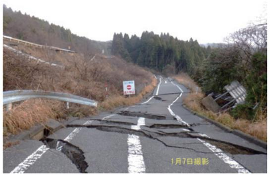
図3 のと里山海道の横田インターチェンジで発生した被害
