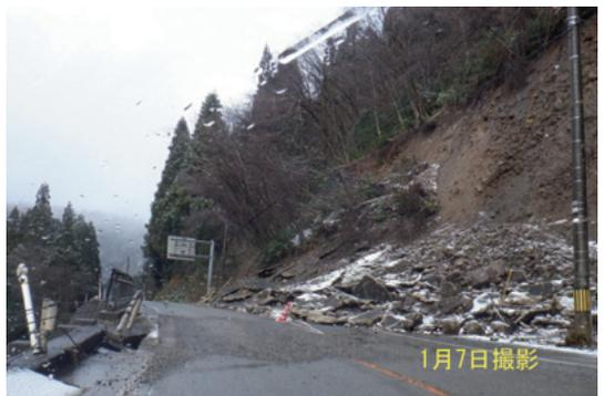
図5 石川県道沿いの斜面崩壊
