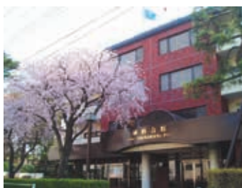
研修会館2号館
