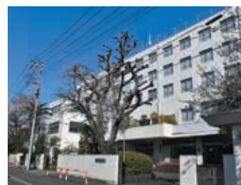
研修会館3号館
