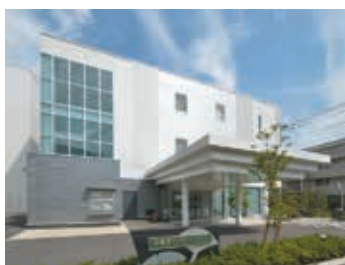
研修会館1号館
