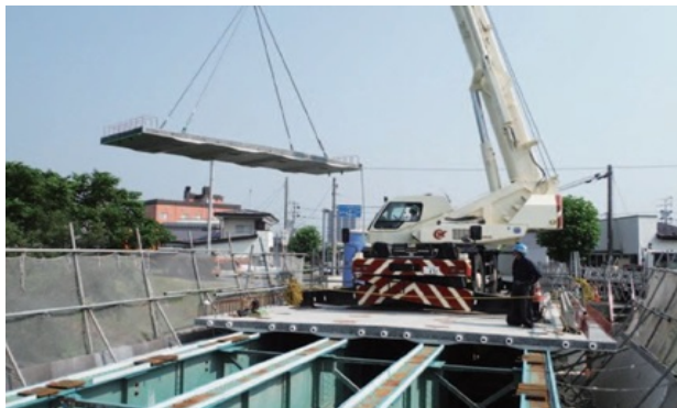
床版の補修工事
