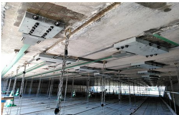
上部工の補修工事
