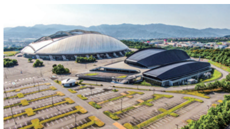
写真1 北西側鳥瞰大分ドームと大分県武道スポーツセンター
