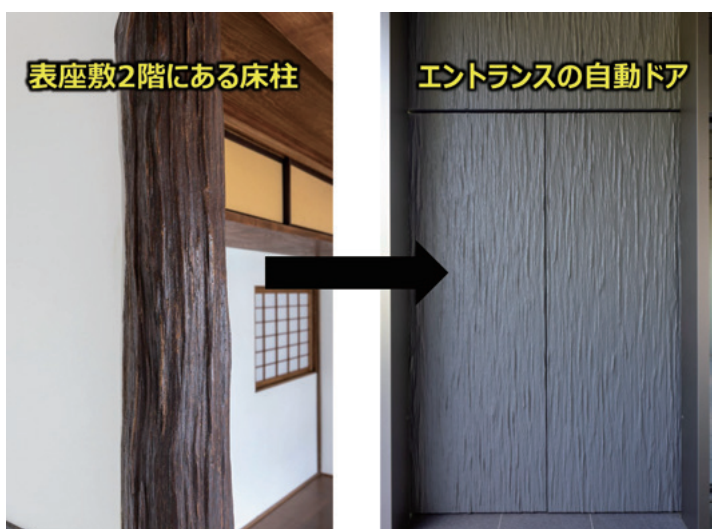
写真9 床柱の模様を再現した自動ドア
