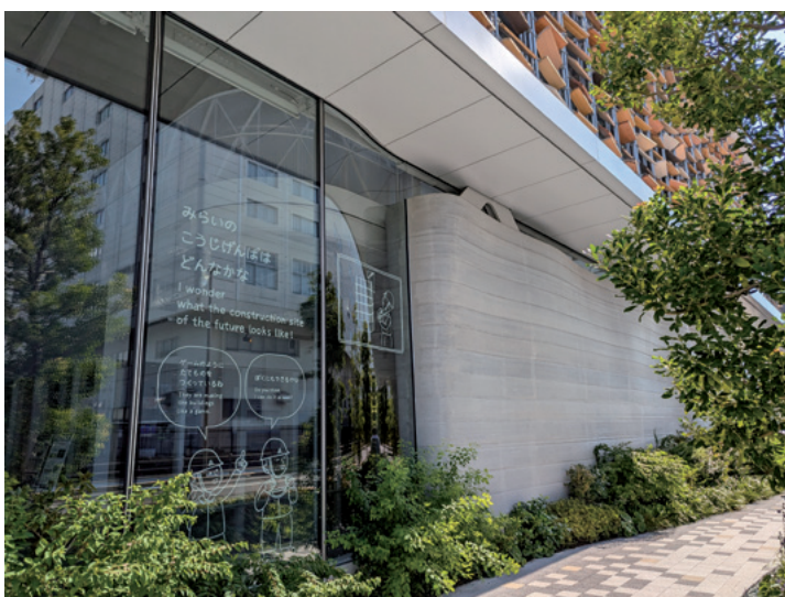
写真7 施工現場のイラストが描かれたガラスと3Dプリンターでつくった壁
