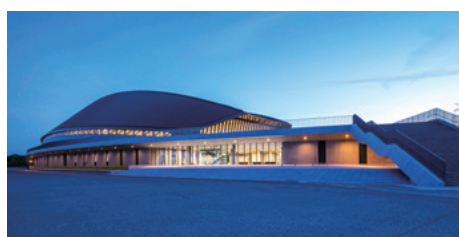
写真3 エントランス夜景
