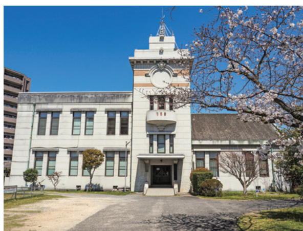
第一庁舎 南面外観（大規模リニューアル前）
