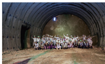
東海北陸自動車道 三尾河トンネル工事
