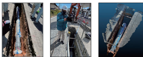
図10 管路点群化の作業イメージ
