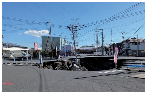
2025年1月30日(木) 陥没拡大後の状況 (埼玉県)復旧工法検討委員会資料より
