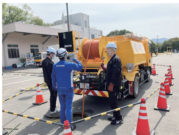
写真7 実際の管路や車両を使った研修（洗浄車研修の様子）
