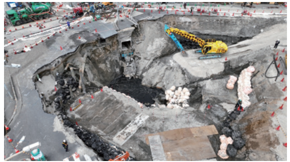
2025年2月12日(水) 現場状況(スロープ設置)
