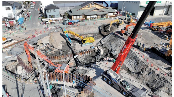
2025年2月28日(金) 現場状況(鋼矢板打設)
