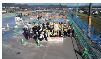
小学生の現場見学会 「東海環状自動車道 七五三高架橋」
