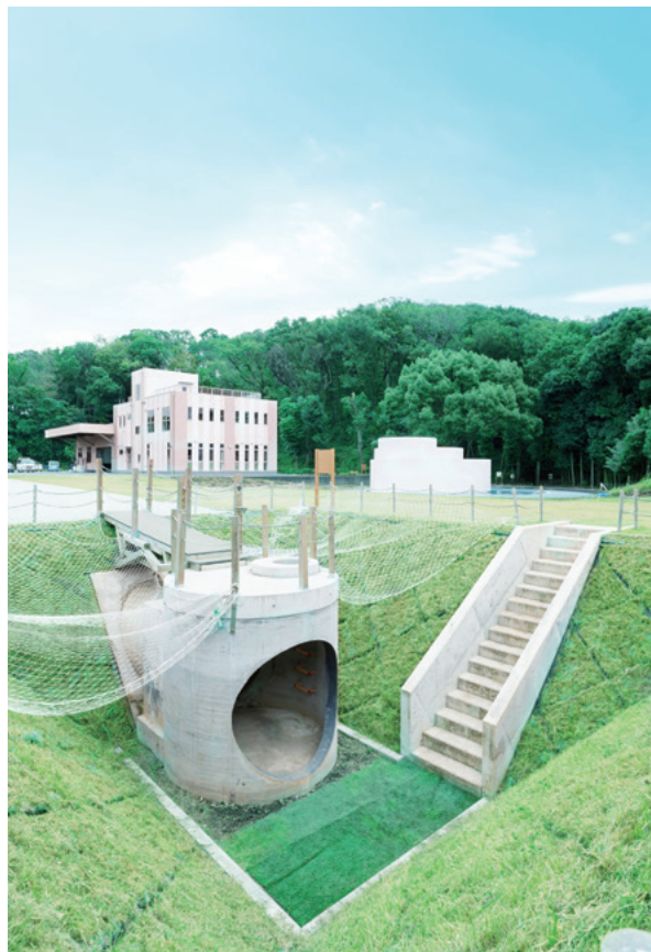
写真1 管径1500mmの「研修用下水道管路」から研修棟、水まもりトイレを望む
