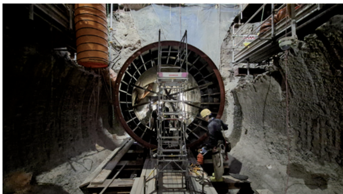
破損した下水道管の補修状況
