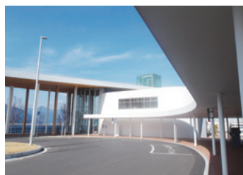
ホーバーターミナル西大分近景
