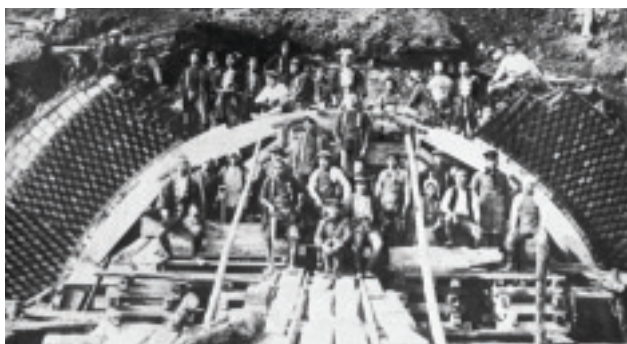
写真4 工事中の丹那トンネル
