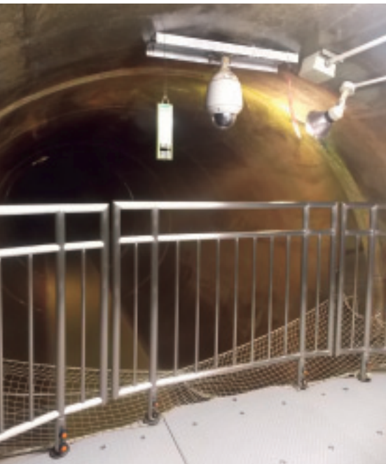
上／地下5階の体験室にある府中街道の下を通る下水道の本管。監視カメラやライト、温・湿度計などが天井から下がっている。右上／地下2階の暮らしと下水道をテーマとした展示室。大きなトイレや洗面台の模型を使って生活水の動きを表現。その他、昔の下水道の仕組みや、現在の下水道など、マジックビジョンを使って解説する。右下／地下3階、小平の水資源をテーマとした展示室には、昔の井戸の模型や井戸掘り用具、玉川上水流域の動植物の写真などを展示・解説している。
