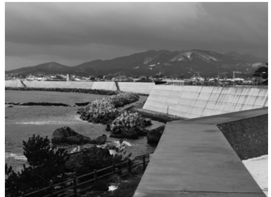
伝承館にほど近い岩井崎海岸の防潮堤
