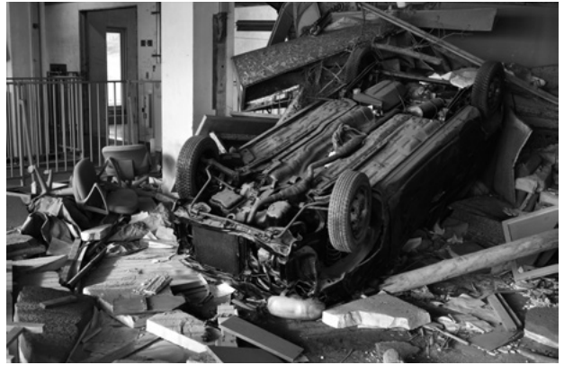
南校舎3階には漂着した車が仰向けのまま残されている
